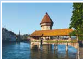
Kappelbrücke, Kanton Luzern
